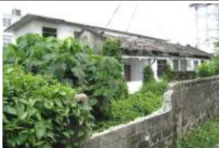
照片 8：貿易六村位在勝利街東北側的入口（2011/4/9）。
