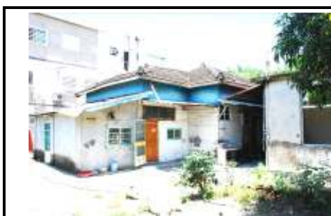
照片 1：東英新村的日式宿舍及雨淋板外牆（2011/7/1）。
